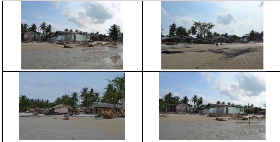
Gambar 6. Kondisi Pantai Tanjung Lapin Desa Tanjung Punak Kecamatan Rupat Utara Akibat abrasi sebelum adanya pengaman pantai
